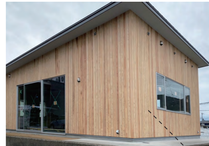
竣工時のOw 国産杉 縦張り エムフェクト:クリア塗装
